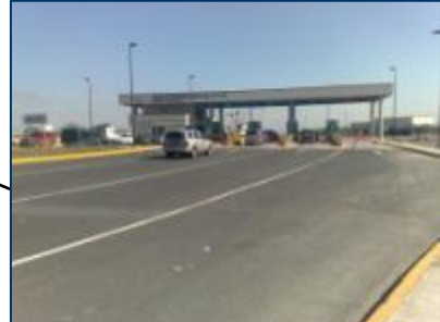
PUENTE INTERNACIONAL REYNOSA/ANZALDÚAS (CONCESIÓN)
