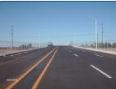
PUENTE INTERNACIONAL SAN LUIS RÍO COLORADO II (CONCESIÓN)
