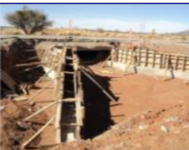
ESTACIÓN DON - NOGALES (OBRA PÚBLICA NO PRESUPUESTAL)
